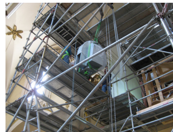
Proceso de instalación del nuevo motor. Foto Gerhard Grenzing S.A. ▶
